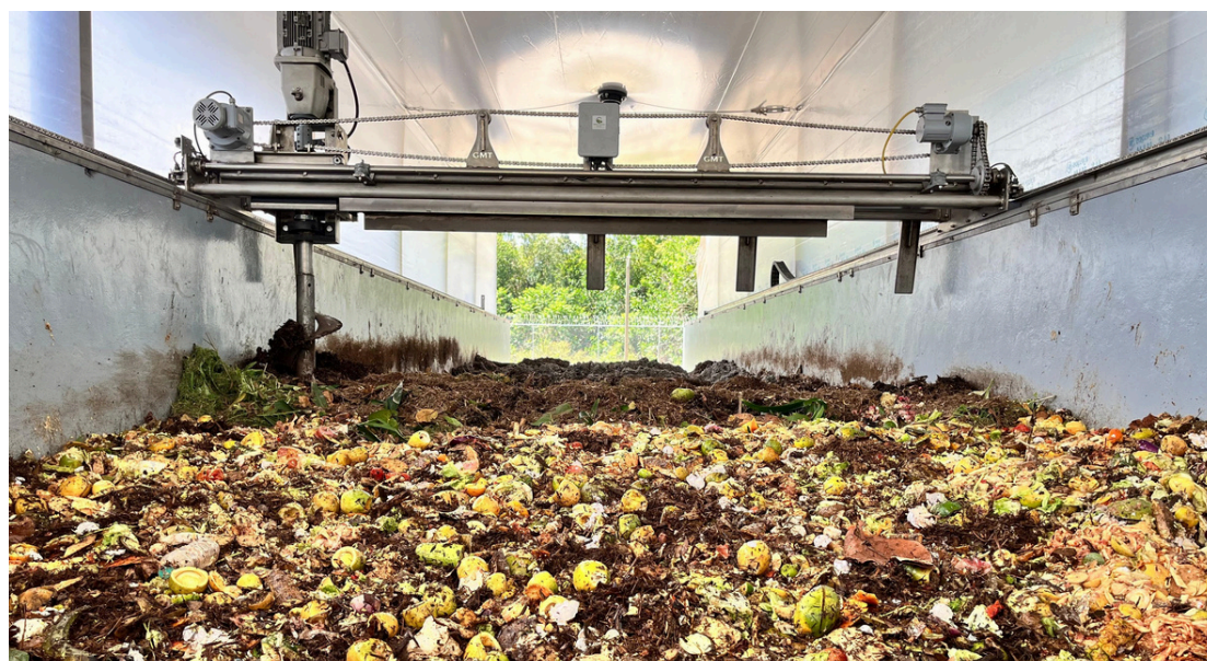
Centro de Valorización de Residuos del Este (CENVAREE), Fundación Grupo Puntacana's waste valorisation centre.
